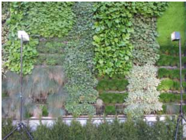
MESURES IN-SITU DES PROPRIÉTÉS ABSORBANTES (IMPÉDANCE ACOUSTIQUE) D'UNE FAÇADE VÉGÉTALISÉE - © IFSTTAR
