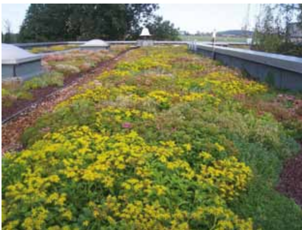
TOITURE VÉGÉTALISÉE EXPÉRIMENTALE ÉTUDIÉE AU CEREMA – DIRECTION TERRITORIALE EST.
