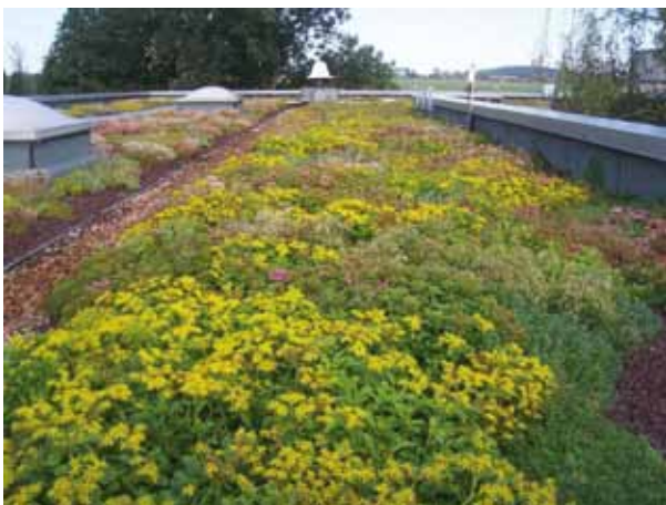
TOITURE VÉGÉTALISÉE EXPÉRIMENTALE ÉTUDIÉE AU CEREMA – DIRECTION TERRITORIALE EST.
