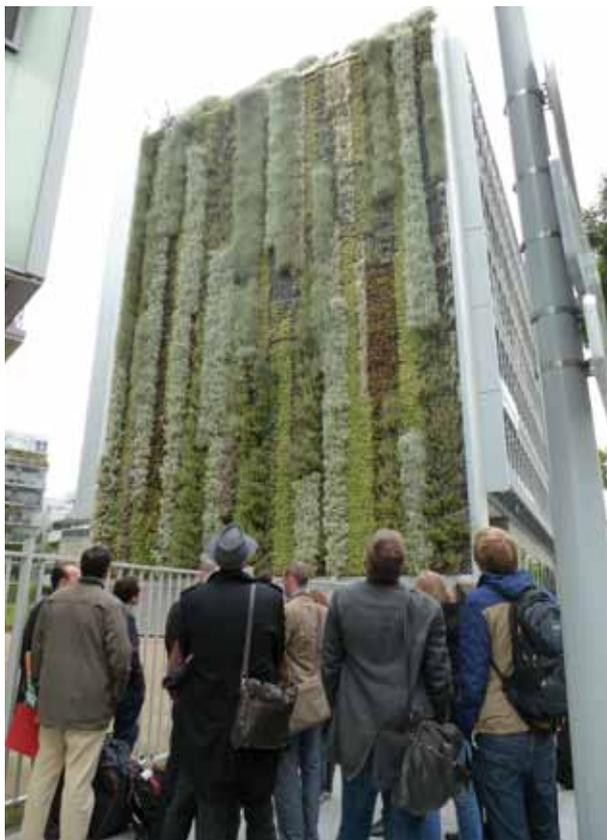
FIGURE 2 : EXEMPLE DE MUR VÉGÉTALISÉ CANEVAFLOR (CAGES MÉTALLIQUES) QUARTIER SEGUIN RIVES À BOULOGNE-BILLANCOURT - © PLANTE & CITÉ
