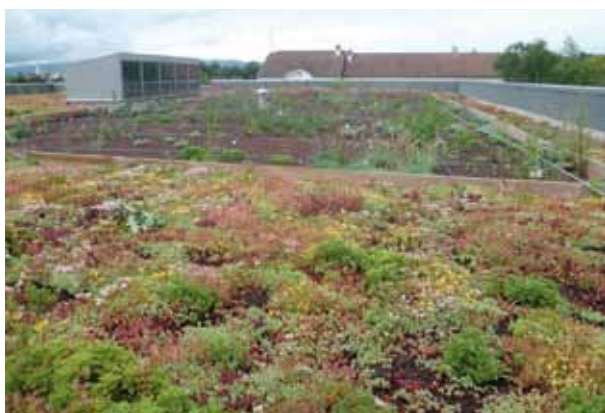
FIGURE 2 : SITE D'ESSAI GAMME VÉGÉTALE EN TOITURES EXTENSIVES À LYON (PIERRE DELHOMMEAU-EPLEFFA LYON-DARDILLY-ECULLY)
