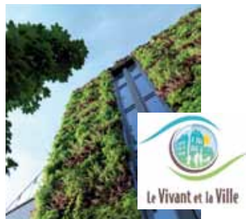
FAÇADE DU MUSÉE DU QUAI BRANLY À PARIS CONÇUE PAR PATRICK BLANC © COUVERTURE DU « GUIDE DES BONNES PRATIQUES DES ENVELOPPES VÉGÉTALISÉES DU BÂTI »
