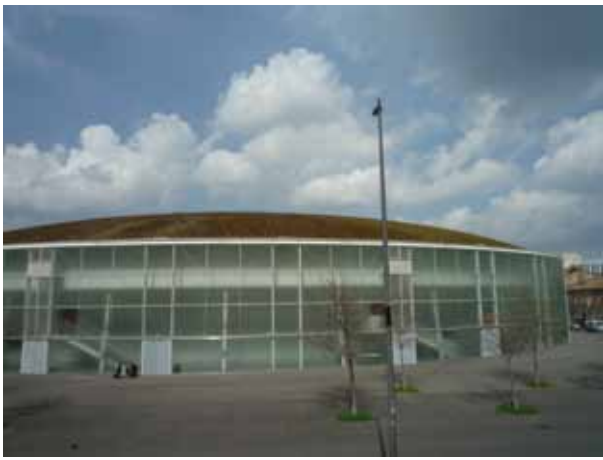
LA TOITURE EMBLÉMATIQUE DU PALAIS DES SPORTS - © MAIRIE DE TOULOUSE
