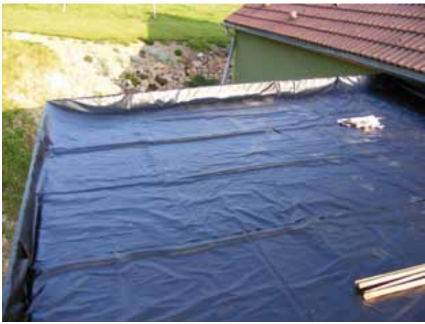
UNE BÂCHE RÉSISTANTE EST APPLIQUÉE SUR LE TOIT - © P. PUECH
