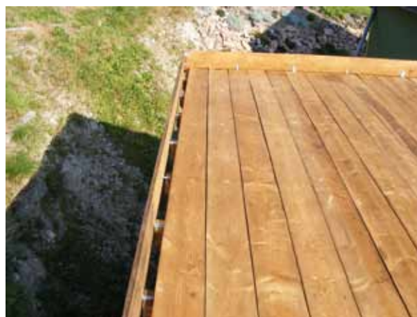
TOIT AVANT LES TRAVAUX - © P. PUECH
