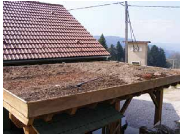
MISE EN PLACE DU SUBSTRAT SUR LA TOITURE - © PATRICK PUECH
