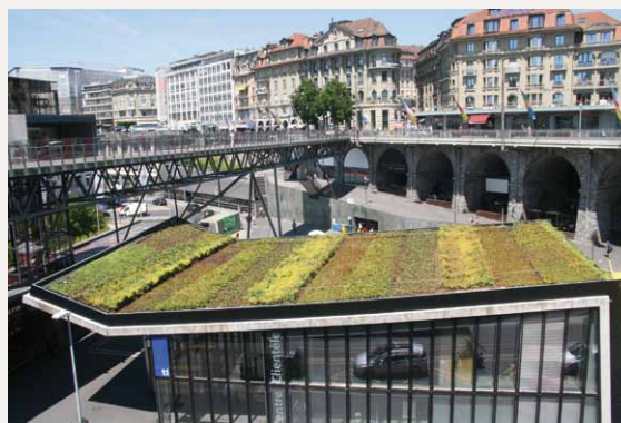
TESTS DE VÉGÉTALISATION DE TOITURES À LAUSANNE - © J.-F. COFFIN
