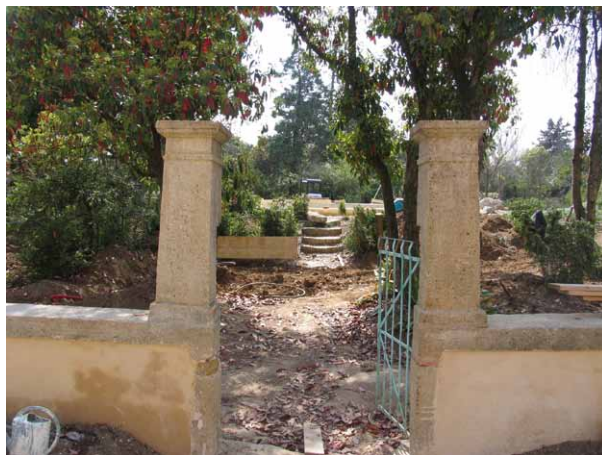
LES TRAVAUX DE RESTAURATION DU JARDIN DE L'HARMAS - © P. ABEL - MNHN
