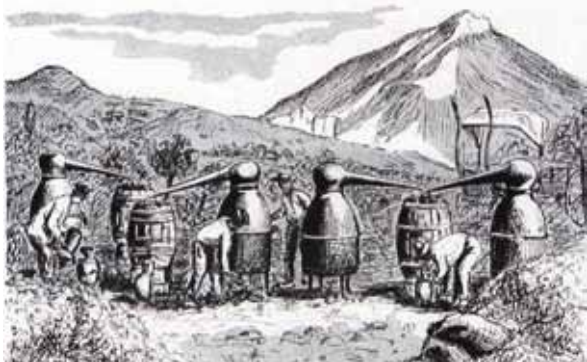
DISTILLATION DE LAVANDE EN HAUTE PROVENCE, ILLUSTRATION DANS LA PARFUMERIE MODERNE, 1908
